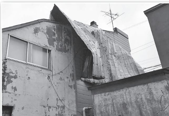
▲昨年末の暴風災害によって屋根が剥がれてしまった家屋
