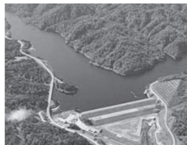
▲小水力発電を導入する留萌ダム
