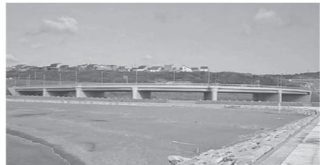
▲橋梁長寿命化事業（ゆうなぎ橋）
