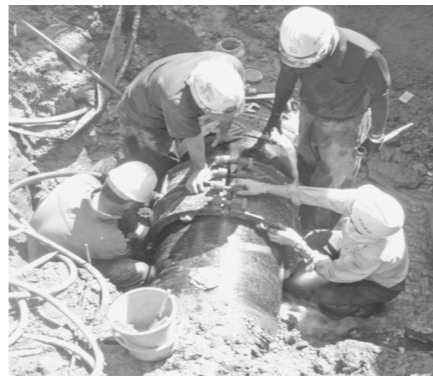
▲送水管の補修
