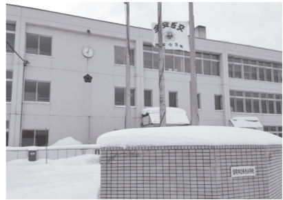
▲耐震補強大規模改造工事が行われる東光小学校
