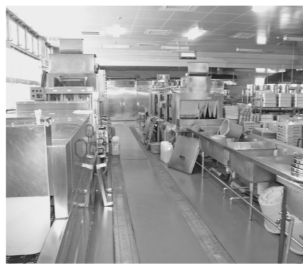
▲調理機器の更新計画が策定された給食センター
