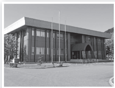
▲留萌浄化センター
