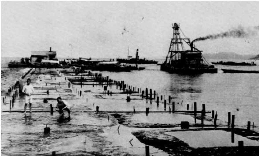
築港工事の防波堤へのケーソンの据え付け
