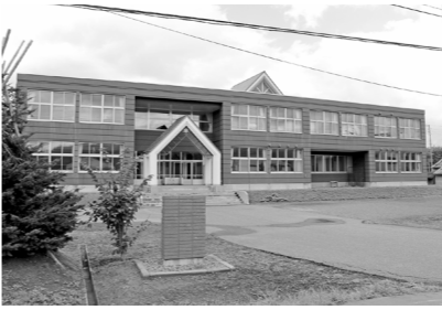
▲製造ラインを整備する旧幌糠中学校
