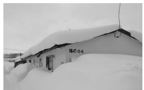
▲雪に埋もれた市営住宅
