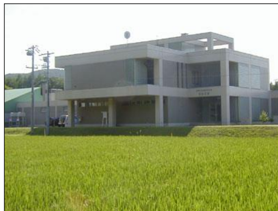
新信砂浄水場
