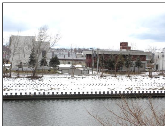
留萌浄化センター
