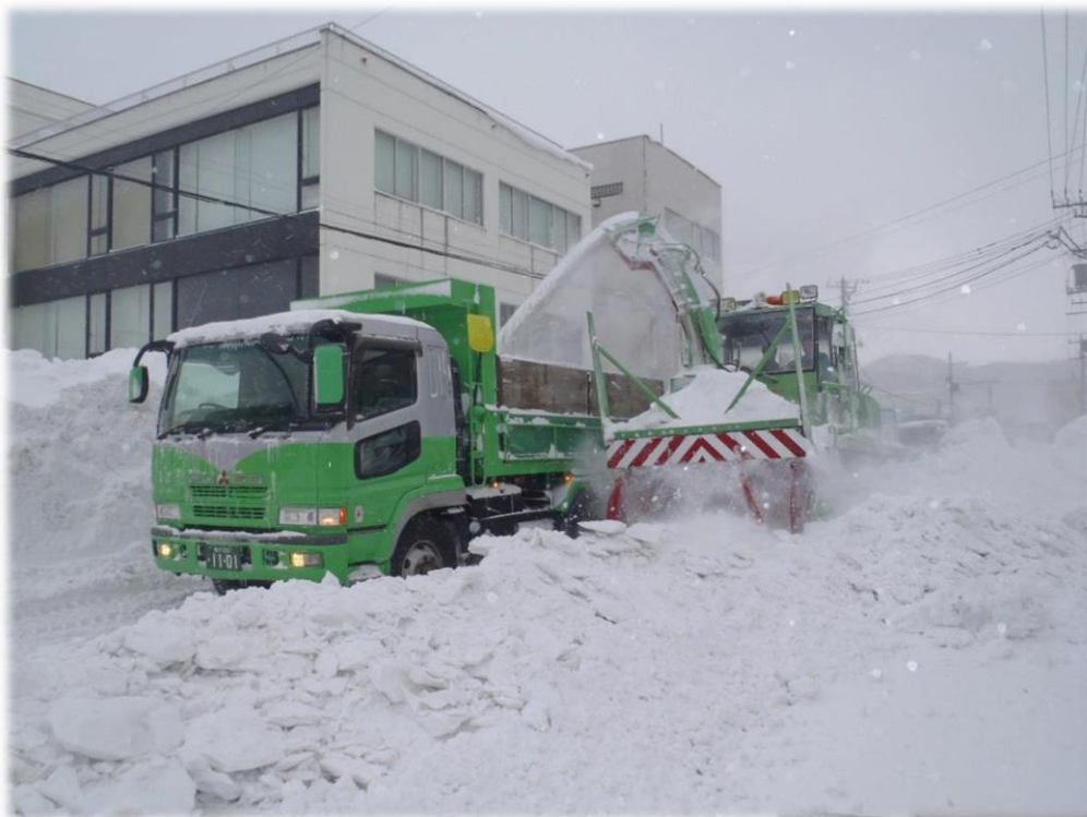
直営排雪状況
