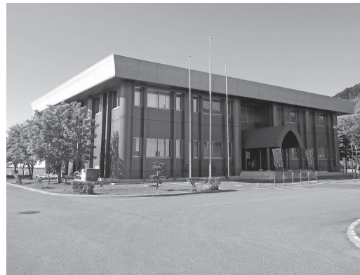
▲留萌浄化センター
