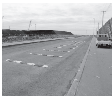
▲車両に付着した石炭などを振動で振るい落とすための移動式ゴム製ハンブ
