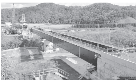
▲「留萌大橋(仮称)工事」(平成27年10月撮影)
