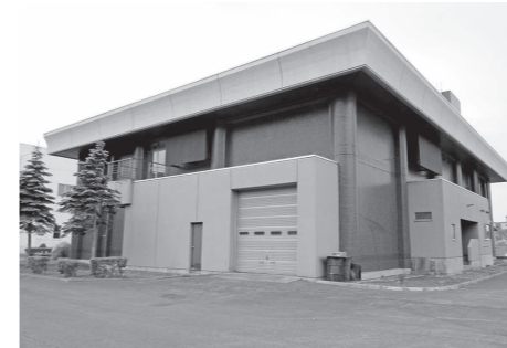
▲浄化センター
