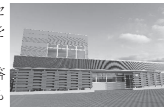
▲5月から供用開始する船場公園管理棟
