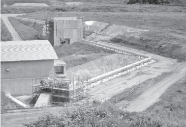
▲留萌ダム管理用小水力発電工事
