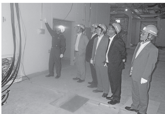
▲完成を間近にした新しい消防庁舎の工事の進捗状況を確認
