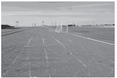
▲危険箇所の修繕などが求められる浜中運動公園
