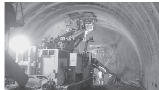
▲留萌トンネル（仮称）掘削状況
