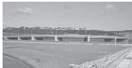
▲橋梁長寿命化事業（ゆうなぎ橋）
