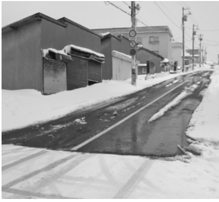
▲平成25年～27年度で改修する北10条通り
