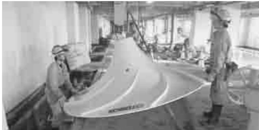
水処理施設内に設置する攪拌装置の設置状況
