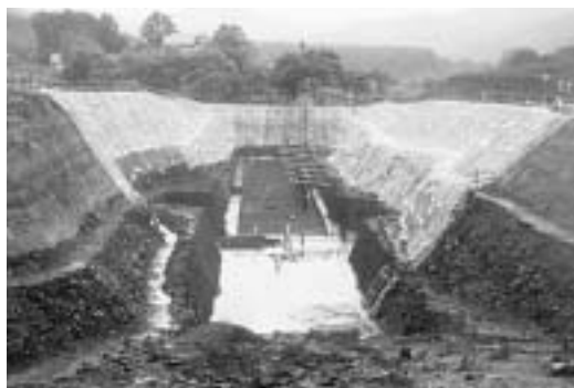
大雨災害で工事が遅れる最終処分場建設予定地
