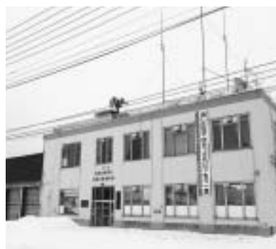
老朽化が進む消防庁舎
