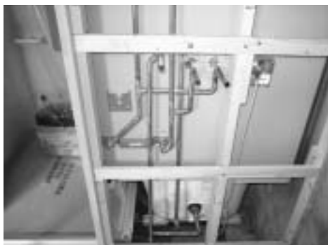
住宅改修工事
