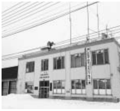
老朽化が進む消防庁舎
