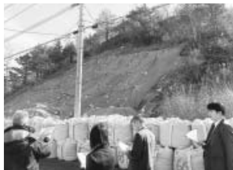
千鳥町自由ヶ丘、法面災害現場
