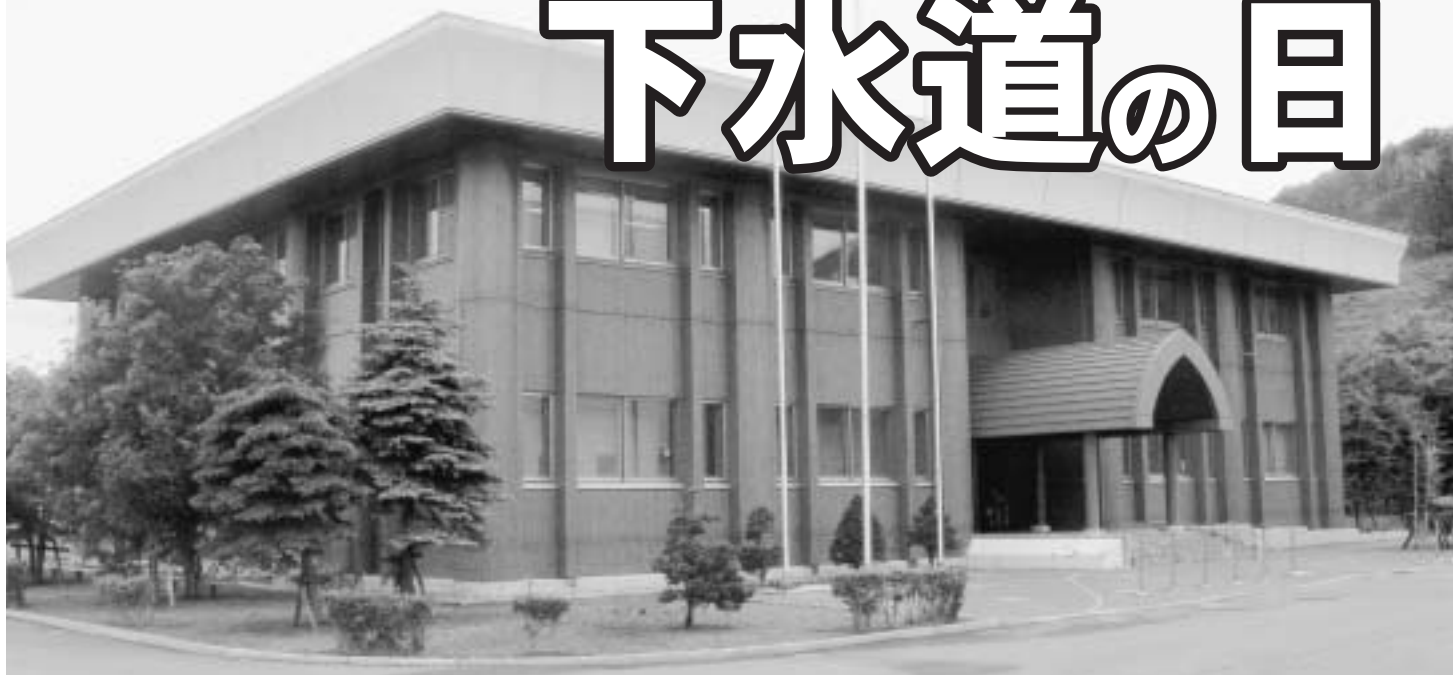
浄化センター
