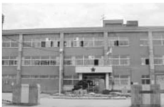
校舎の老朽化が見られる留萌小学校
