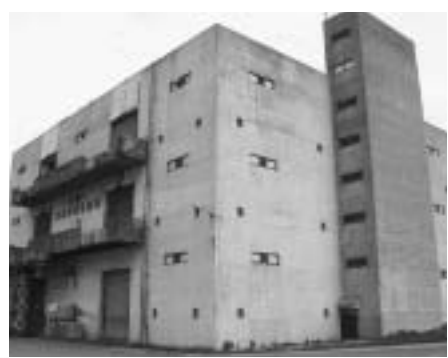
留萌港南岸倉庫
