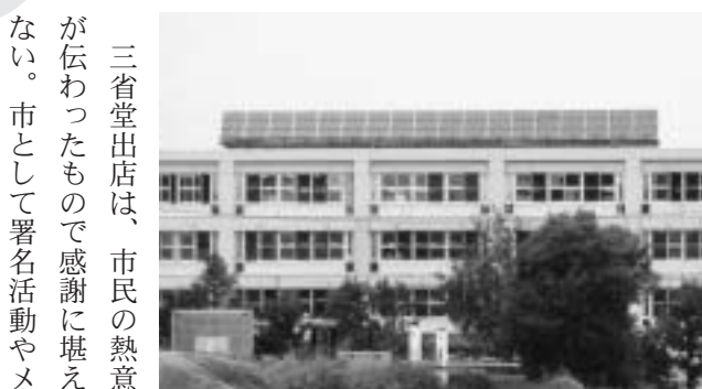
太陽光発電が設備された留萌高等学校
