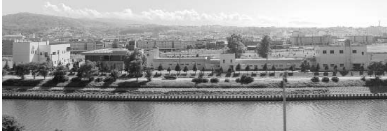
浄化センター全景
