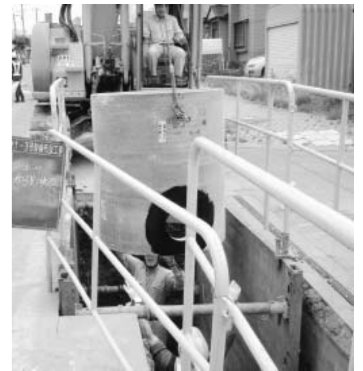
汚水本管の布設状況（大町地区）
