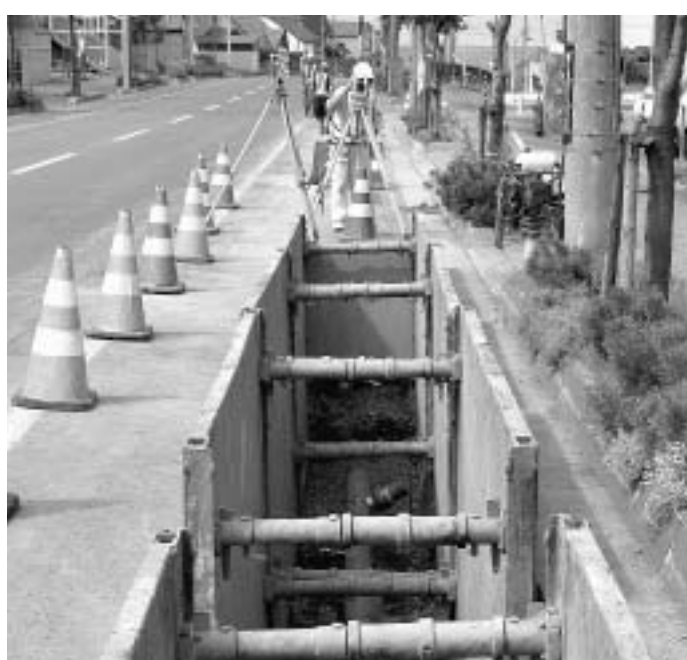
汚水本管の布設状況 《大町地区》
