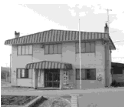
今年度改修予定の港南コミュニティセンター
