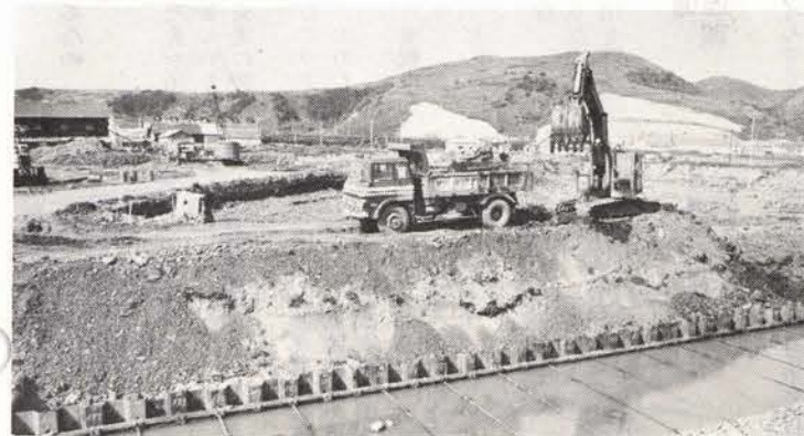
△掘込みが進む東岸船溜り
