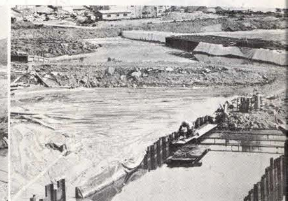
△埋め立てが進む副港工事現場
