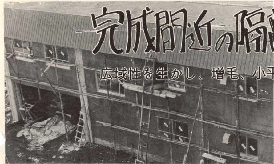
完成が待たれる隔離病舎建設工事
