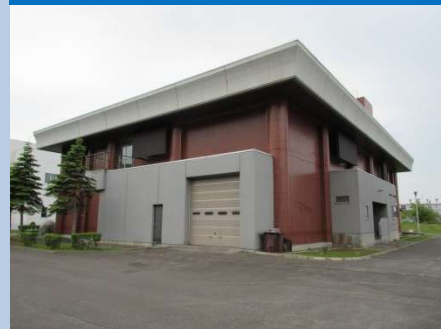
浄化センター
