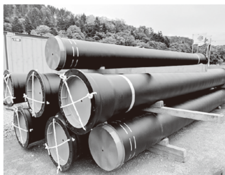
▲72年を経過し老朽化で、昨年更新されたパイプ口径500ミリメートルの導水管（増毛町新信砂）
