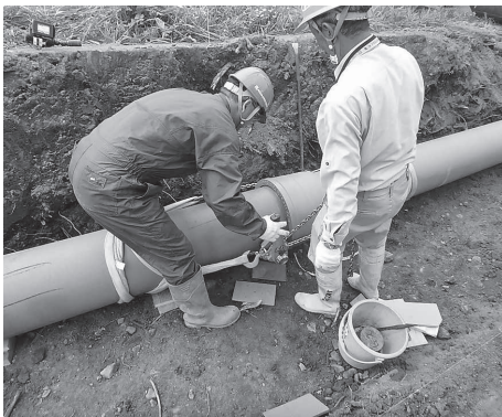
▲水道工事作業の様子
