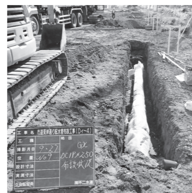
▲配水管工事作業風景
