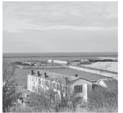
▲広大な三泊ふ頭エリアを洋上風力発電の拠点の活用に向け
