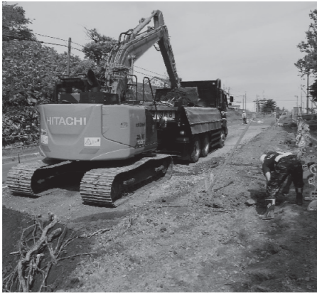
▲南9条通りの道路整備工事
