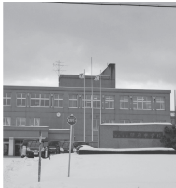
▲大規模改修が行われる留萌中学校
