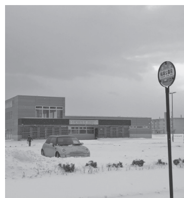
▲船場公園前に新設された豊富留萌線のバス停留所
