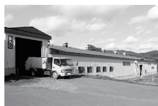
▲生ごみ処理施設
