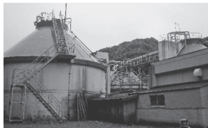
▲し尿処理を行う衛生センター（留萌市）
