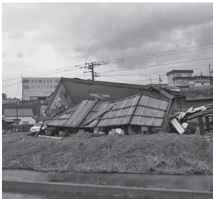
▲11月11日の暴風雨による市内の被害状況
