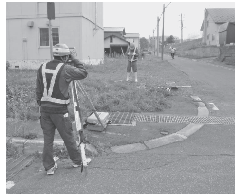
▲見晴通工事のための測量
