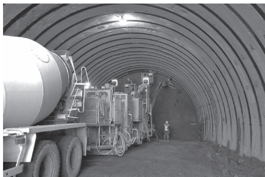
▲バンゴベトンネル(仮称)の掘削工事
