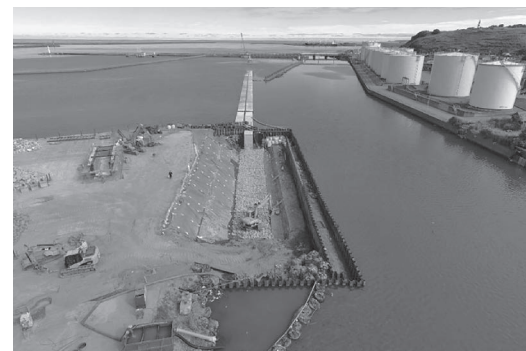
▲留萌川で行われている河口導流堤の建設工事
