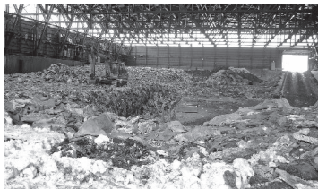
▲火災が発生した不燃系最終処分施設
