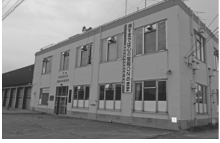
▲老朽化した消防庁舎
