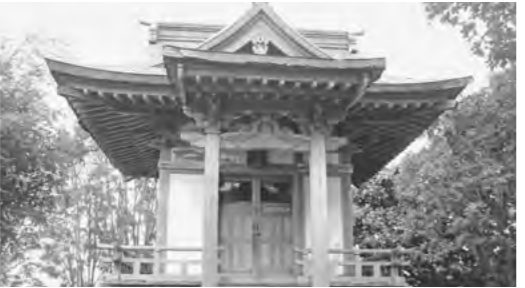
▲損傷と腐食が進む湊神社
