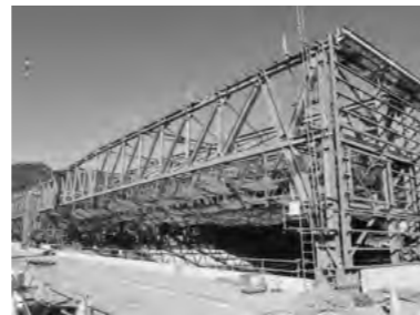
▲建設中の最終処分場
