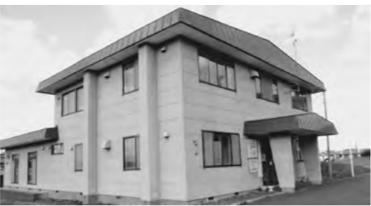
▲指定管理者制度で運営している施設
