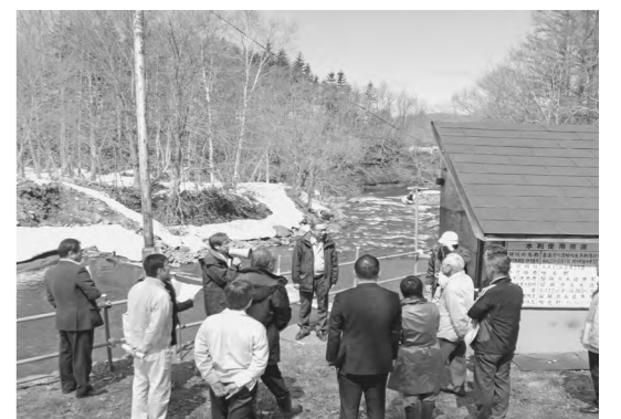
▲老朽化が著しい取水施設（新信砂）
