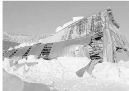
▲倒壊施設（増毛町）
