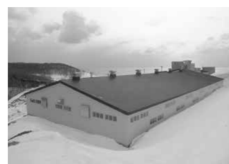
▲小平生ごみ処理施設
