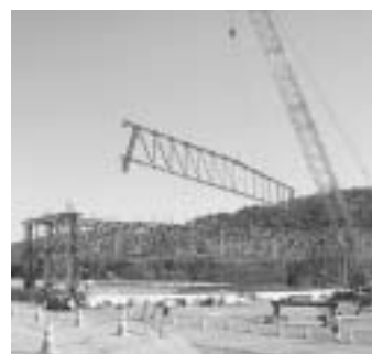
増毛最終処分場の工事状況
