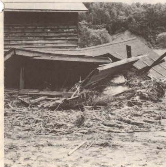
▲崩れた民家（幌糠町）
