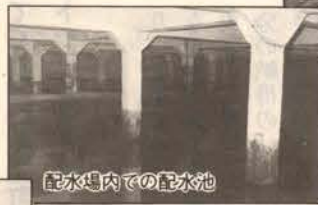
沖見町配水場
