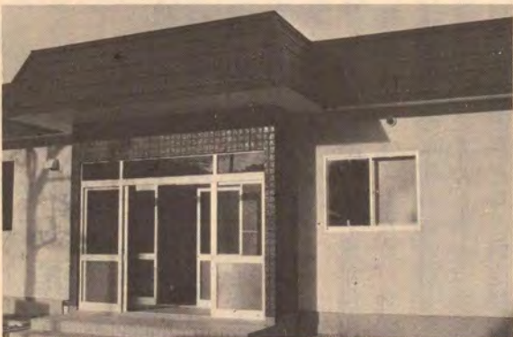
完成した「みどり会館」
